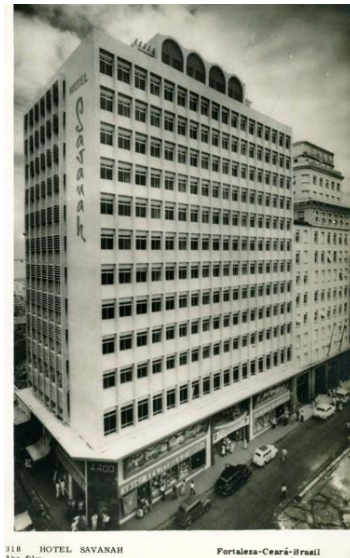
Figura 10 - Edifício Carlos Jereissati - Hotel Savannah (1957).
