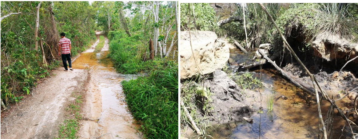
Figura 6 e 7 - Rompimento de estrada pelo retorno da água do Córrego Velha Antônia (2022 - 2023)
