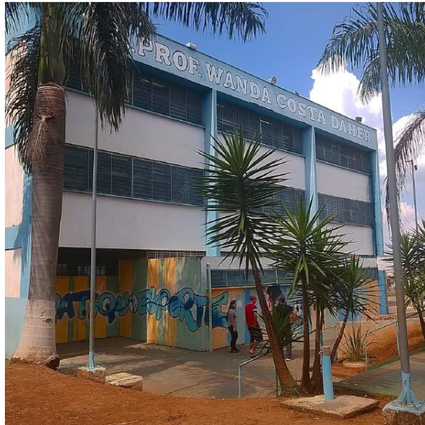
Imagem 02 – Fachada da E.E. Prof. a Wanda Costa Daher (2019)
