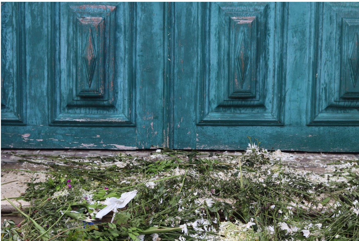
Figura 5 – Escadarias da Igreja Matriz de Nossa Senhora da Purificação após Lavagem.
