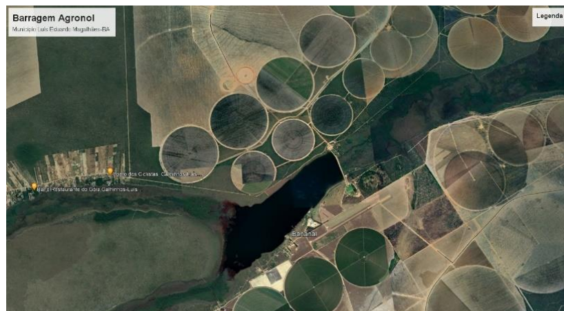
Figura 03: Imagem da barragem Agronol.
