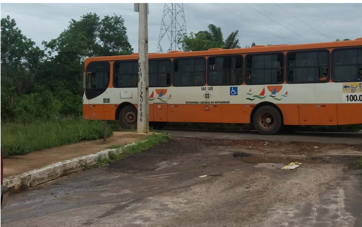
Figura 2 – Ônibus passando ao lado do buraco no Residencial Santo Antônio, em São Luís-MA
