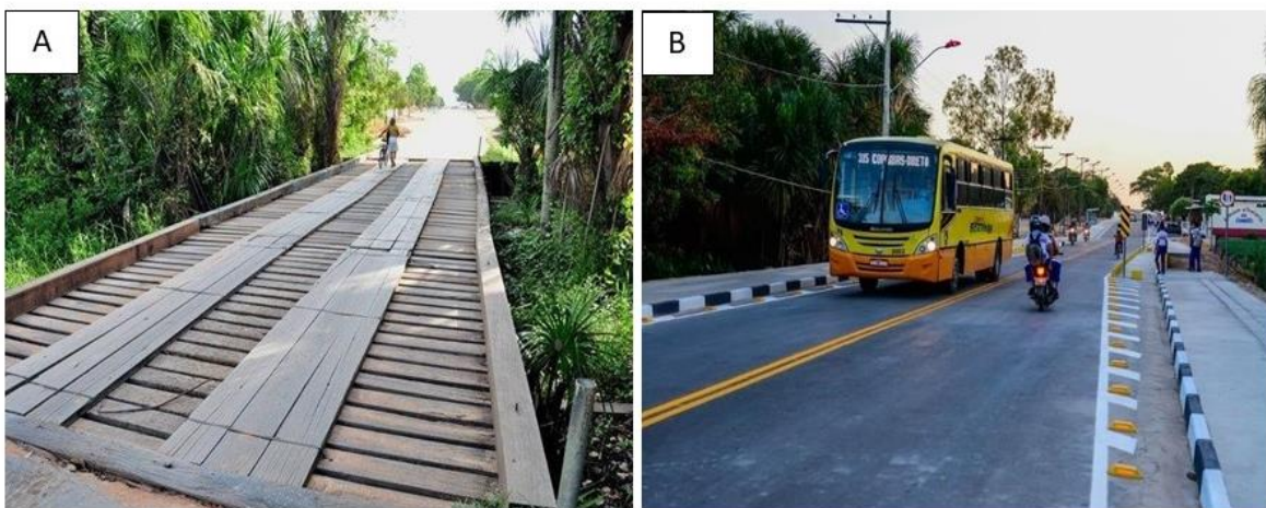
Figura 4 – Antes e depois da ponte que interliga o bairro Airton Rocha ao Nova Cidade: a) Antiga ponte de madeira; b) Ponte de concreto
