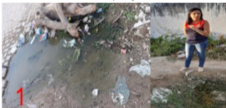
Figura 3: Vazamento localizado na Rua Gumercindo Cavalcante sendo o primeiro ponto de interpretação.
