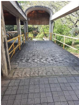
Figura 7 - Corredor de acesso as salas e laboratórios do Instituto de Química
