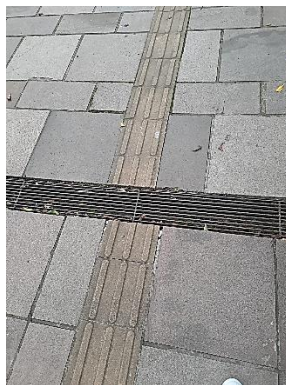
Figura 2 - Calçada lateral de entrada prédio
