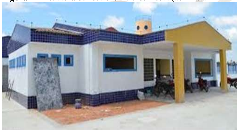
Figura 2 – Estrutura do futuro Centro de Educação Infantil
