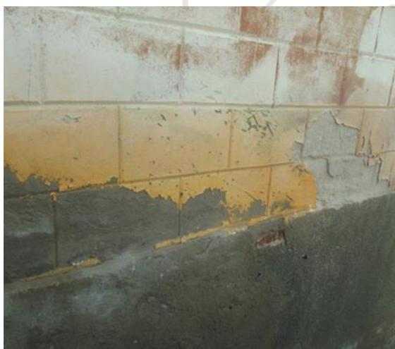
Destacamento da pintura do revestimento juntamente com partes do reboco. Este problema ocorre normalmente quando a tinta foi aplicada antes que o reboco estivesse devidamente curado. Para recuperar/tratar essa região realiza a raspagem das partes soltas, faz a correção das imperfeições profundas com reboco, aplica uma demão de fundo preparador para paredes, diluído na proporção indicada pelo fabricante e finaliza aplicando o acabamento.
