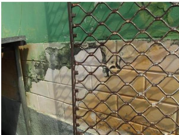
Outro problema muito comum nessa edificação corresponde ao aparecimento de duas patologias, mofo e descolamento do revestimento, em um único local. Isso ocorre principalmente porque existem muitos pontos de umidade na edificação estudada.
