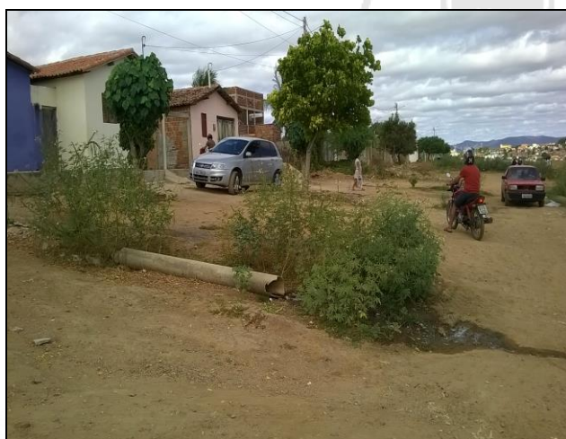
Figura 01: Esgotos a céu aberto no município de Pau dos Ferros – RN
