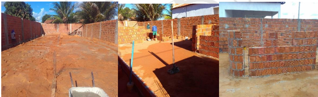
Figura 2: Compactação e levantamento da alvenaria
