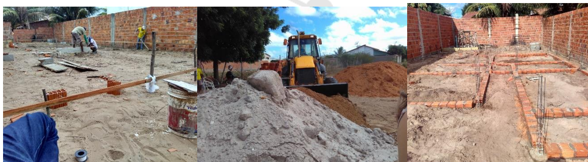
Figura 1: Etapas Iniciais da Obra
