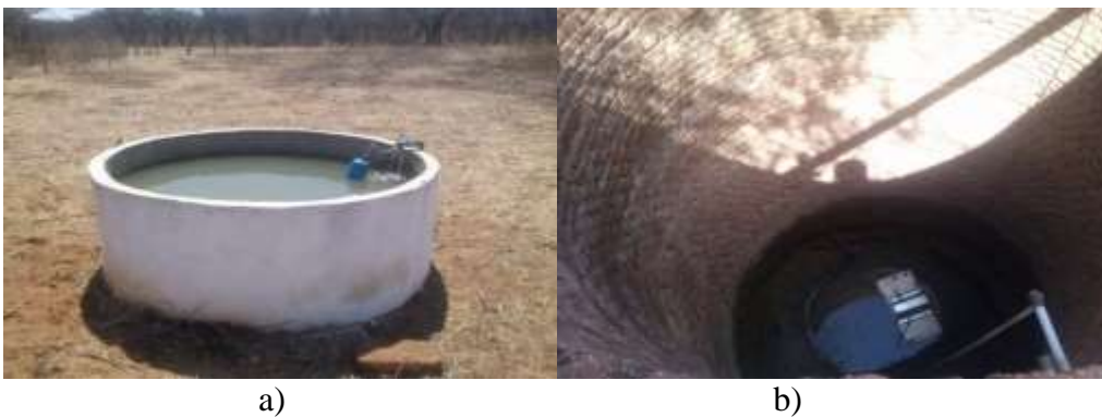
Fig. 03 – a) Tanque no sítio Timbaúba, b) Poço Amazonas no sítio Timbaúba
