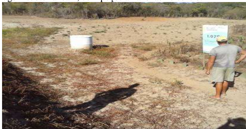
Figura 3. Vista da barragem subterrânea 2, instalada no Sítio Barriguda II, Barra de Santana, PB.
