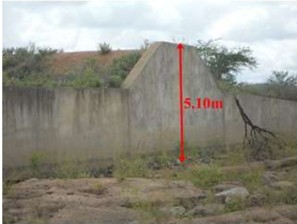
Figura 1: altura da face lateral do vertedor.
