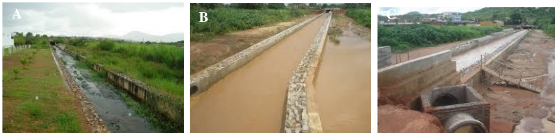
Figura 2. Situação atual da preservação do Riacho Agon em Catolé do Rocha – PB (A, B e C).
