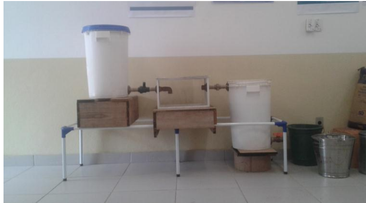
Figura 1 – Sistema construído em escala piloto, constituído por tanque de alimentação, tanque séptico e FIA (esquerda para direita)
