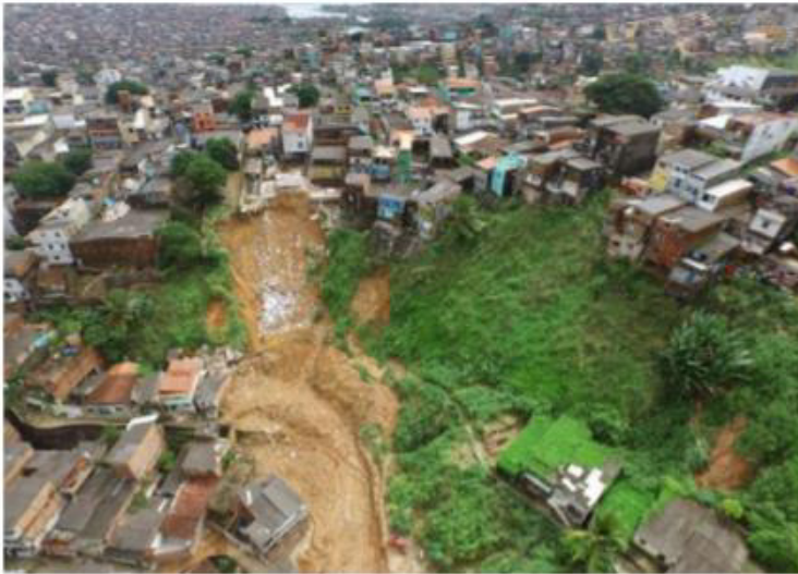
Figura 9 - Deslizamento de terra na comunidade Barro Branco.
